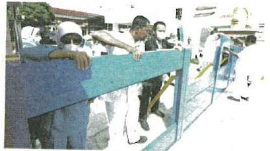
Petugas HRPZ II melakukan latihan amali memasang penghadang banjir bagi mencegah kejadian banjir besar luar jangka seperti bah kuning.
