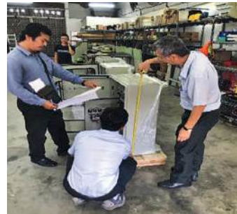
Pengujian Papan Agihan Utama (DB) bagi Projek Kerja Penggantian Lif di Hospital Teluk Intan dan Hospital Selayang
